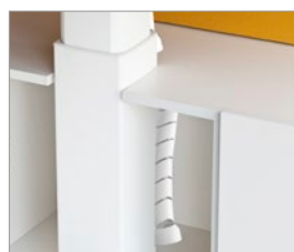
Elevation of PE cables.
